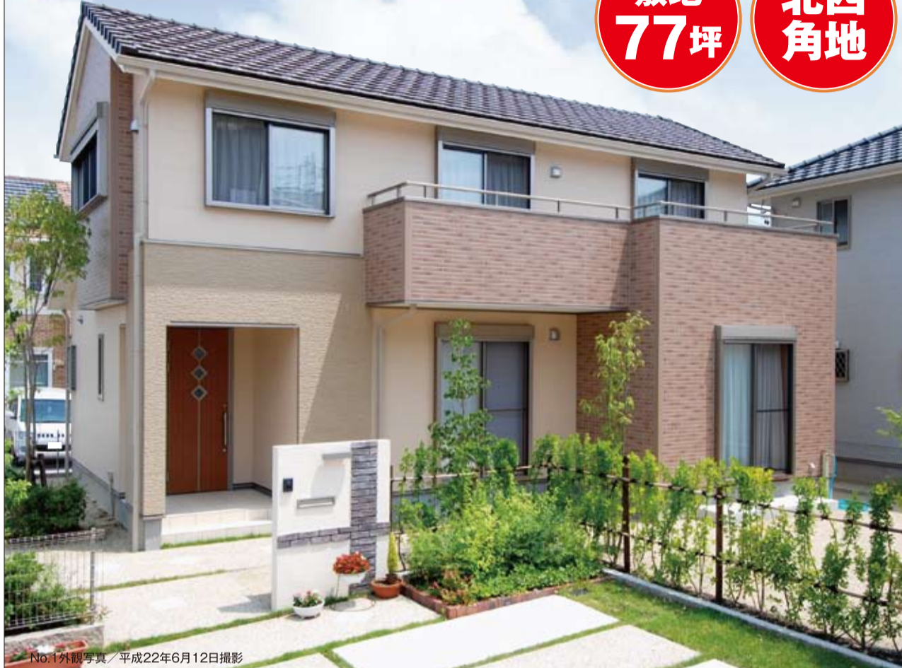
No.1 外観写真 / 平成22年6月12日撮影
